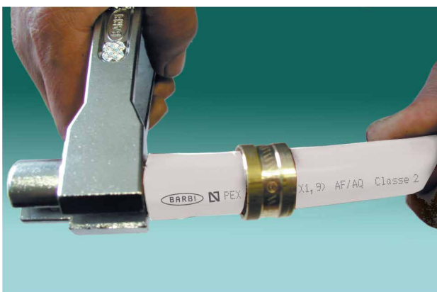
3 - Alargar a extremidade do tubo com o Alargador de tubos. O alargamento deverá ser realizado gradualmente, girando o alargador, expandindo progressivamente a ponta do tubo.
