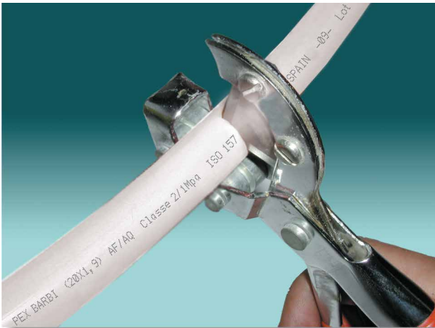
1 - Cortar o tubo com a tesoura BARBI, garantindo que o corte seja limpo e perpendicular.
